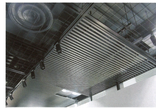
天井ルーバー
