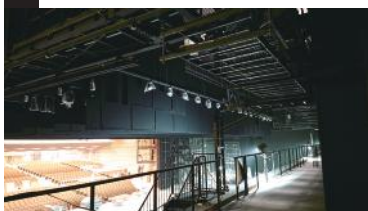
▲熊本城ホール 4F 大ホールステージ上
